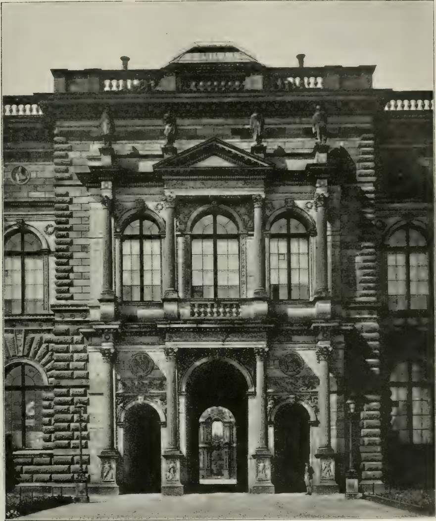
GOTTFRIED SEMPER: NORDEINGANG DER DRESDNER GALERIE
